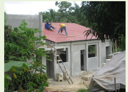
Seitenansicht vom Neubau der Grundschule in Meyer.
